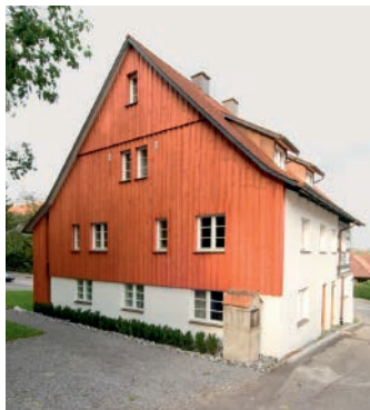
Mit der Sanierung erhielt das Haus einen Bretter-schirm an der Westseite. Foto Hermann Rupp.
