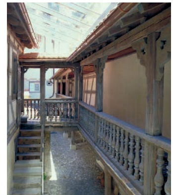
Der Hof erhielt zum Teil eine Glasüberdachung, um die alten Gebäudeteile vor Witterungseinflüssen zu schützen. Foto Maria und Werner Berschneider
