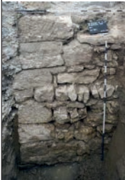
61 Der Wehrturm gründet auf einem 2 m tiefen Fundament, die Ecke ist durch römische Spolien gesichert.
