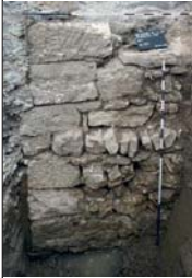
61 Der Wehrturm gründet auf einem 2 m tiefen Fundament, die Ecke ist durch römische Spolien gesichert.
